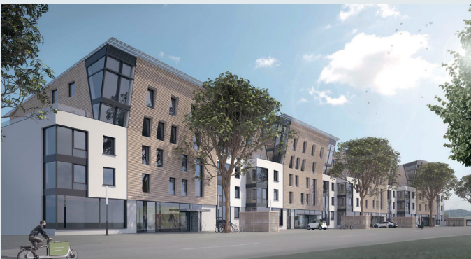
Wohnsiedlung für die Zukunft: In den Plusenergie-Klimahäusern in Schallstadt unterstützt die Komfortlüftung von Meltem das klimaneutrale Energiekonzept. Bild: freidimension
