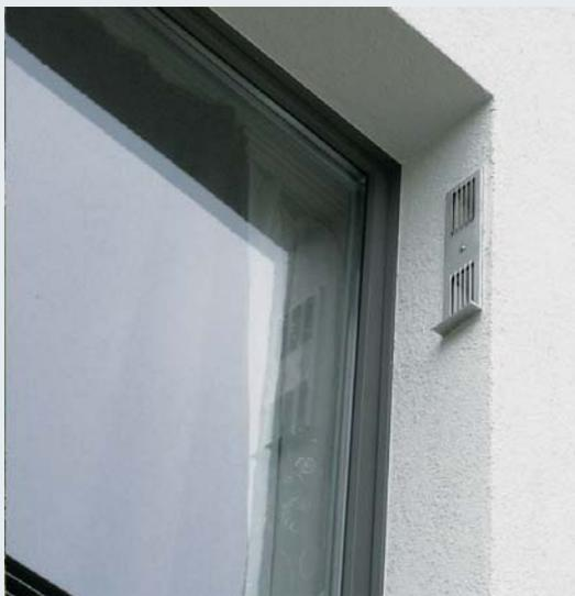
Die Fensterlaibungslösung verbindet den Wunsch des Architekten nach einer optisch unbeeinträchtigten Fassadengestaltung mit den technischen Vorteilen eines dezentralen Lüftungssystems mit Wärmerückgewinnung.
