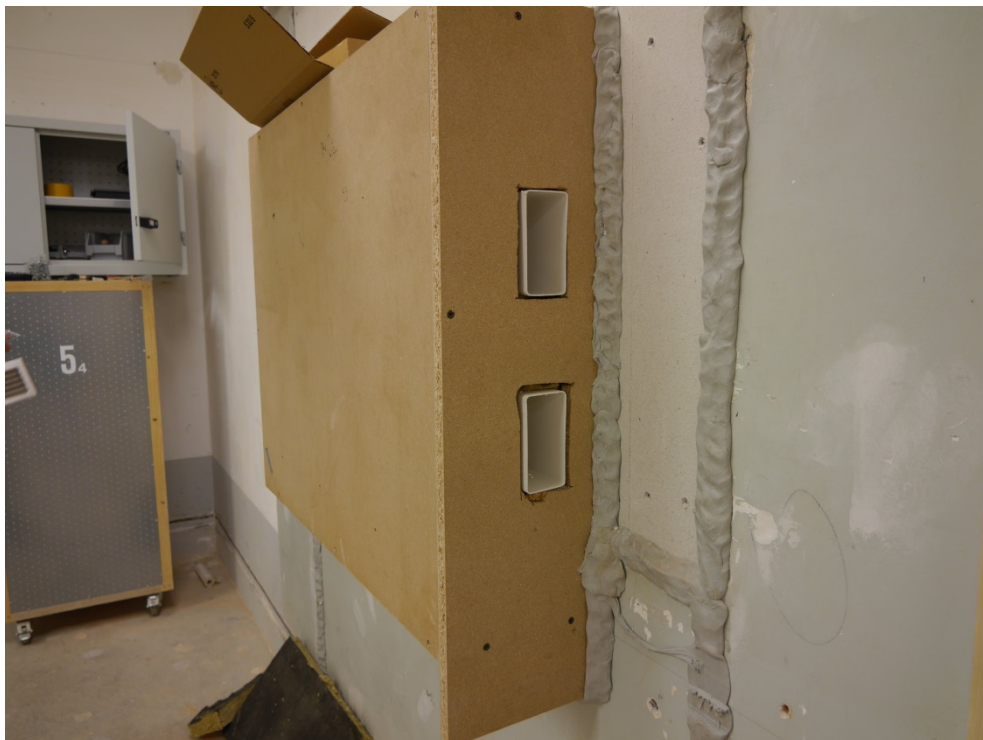
Abbildung B.2. Außenseitige Lüftungsöffnungen in der nachgebildeten Fensterlaibung (Außenluft oben, Fortluft unten), Fassadenabschluss noch nicht montiert.
