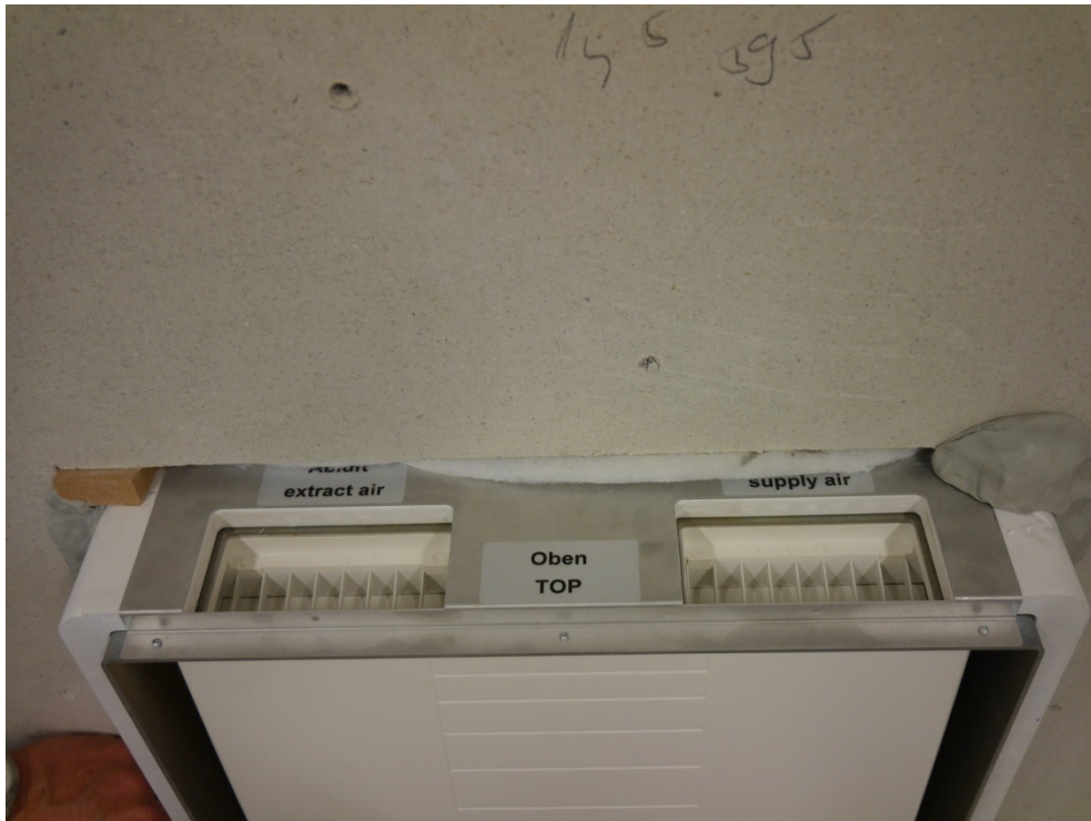
Abbildung B.5. Einbauvariante U 2 : Raumseitige Ansicht Lüftungsgerät mit Lüftungsöffnungen (Zu- und Abluft) vor Montage der Vorsatzschale sowie der Anschlusskanäle, Abdichtung zum Prüfstand noch unvollständig.
