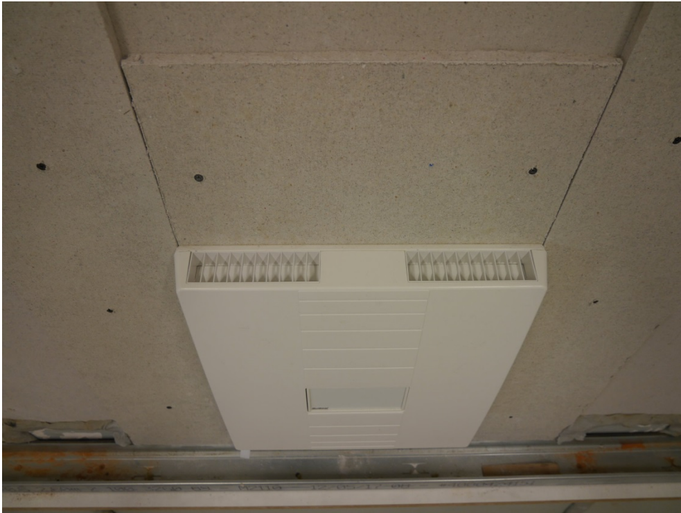
Abbildung B.17. Einbauvariante M-WRG-M (-MB) UP-Standard: Raumseitige Ansicht Oberseite Lüftungsgerät mit Gerätedeckel und Lüftungsöffnungen (prüffertig).
