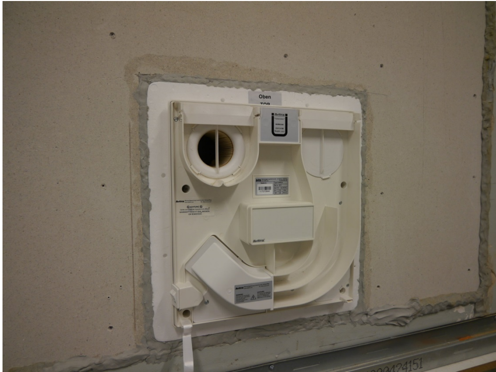
Abbildung B.15. Einbauvariante M-WRG-M (-MB) UP-Standard: Raumseitige Ansicht Lüftungsgerät ohne Gerätedeckel.
