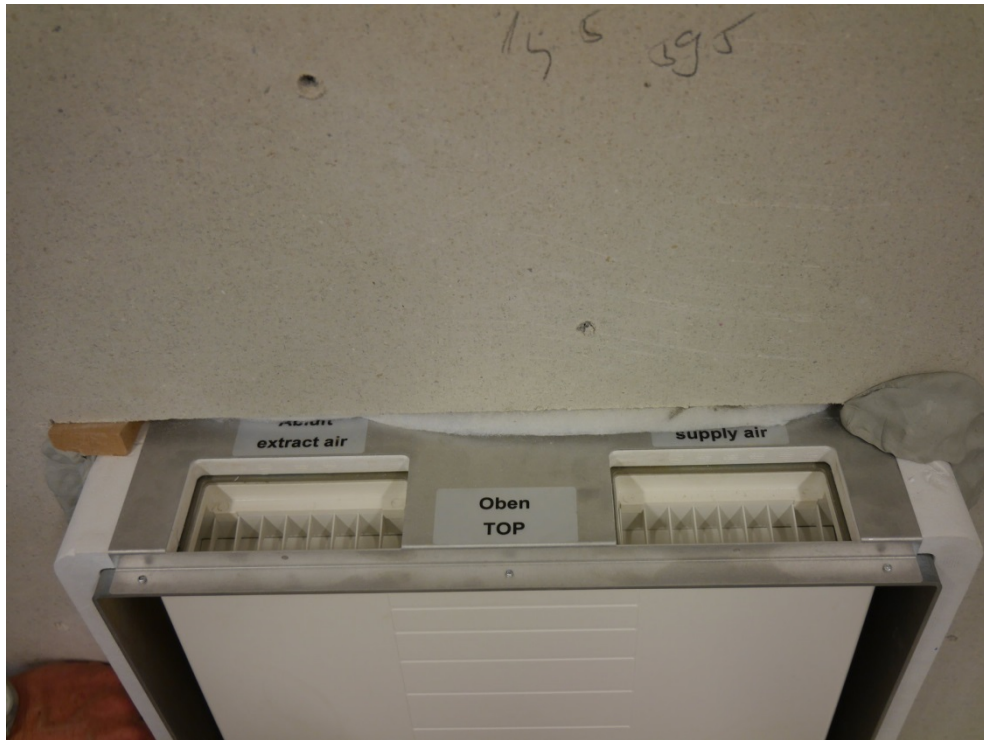
Abbildung D.3. Lüftungsgerät innenseitig mit Lüftungsöffnungen (Zu- und Abluft) vor Montage der Vorsatzschale sowie der Anschlusskanäle, Abdichtung zum Prüfstand noch unvollständig.
