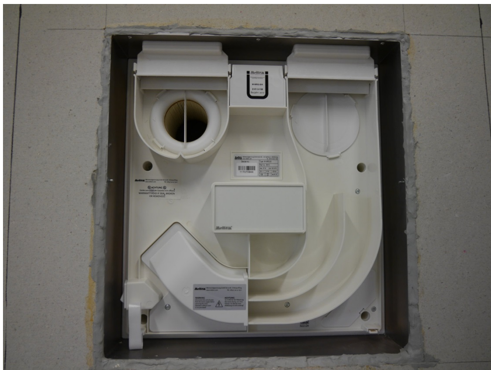
Abbildung D.6. Ansicht Lüftungsgerät innenseitig nach Montage der Vorsatzschale, Gerätedeckel entfernt.
