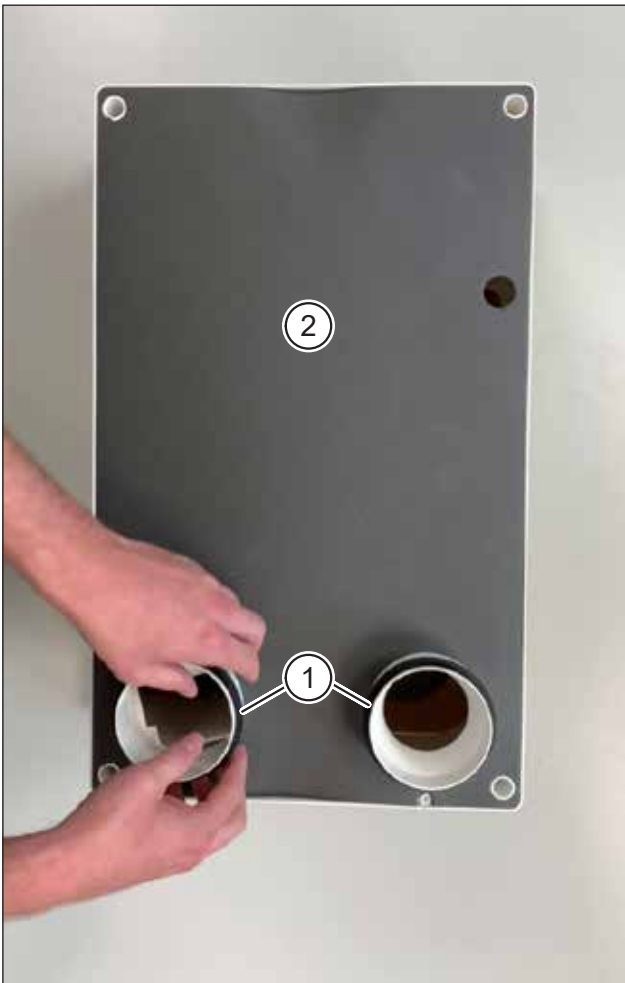
Abb. 9: Dämmung und Dichtungen an Gehäuserückseite entfernen
