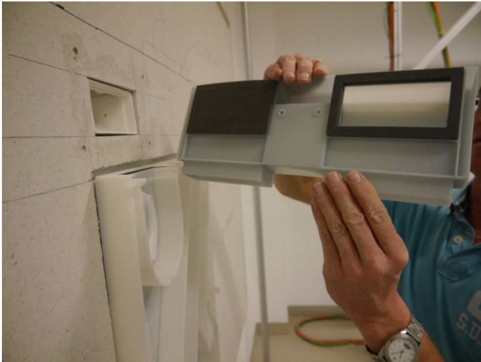
Abbildung B.16. Aufsetzen des Kanaladapters für UP-Einbau mit Kanalanschluss ABL-seitig.
