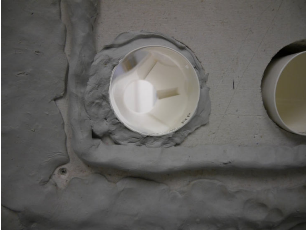
Abbildung B.3. Durchführung der Lüftungsrohre zu den Außenöffnungen durch die Trockenbaublende im Fensterprüfstand; links mit umlaufender Abdichtung, rechts noch ohne Abdichtung.
