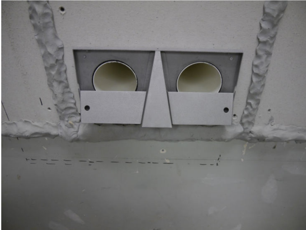
Abbildung B.5. Lüftungsöffnungen außenseitig mit teilweise montiertem Fassadenabschluss (Wandhalterung der Edelstahlsschote).
