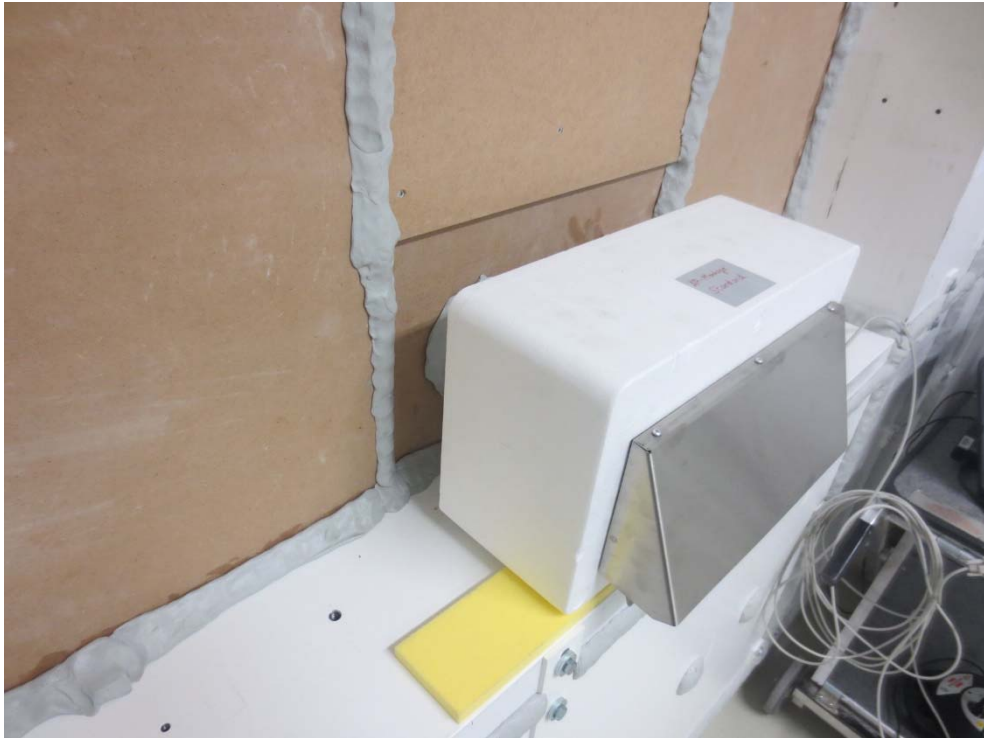
Abbildung B.1. Ansicht Außenseite von schräg links (prüffertig): Fassadenabschluss Edelstahlschote auf Rohrträger (EPS) montiert.
