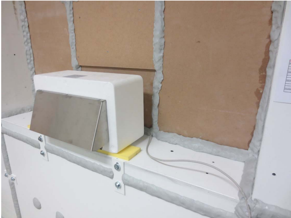
Abbildung B.3. Ansicht Außenseite von schräg rechts (prüffertig): Fassadenabschluss Edelstahlsschote auf Rohrträger (EPS) montiert.
