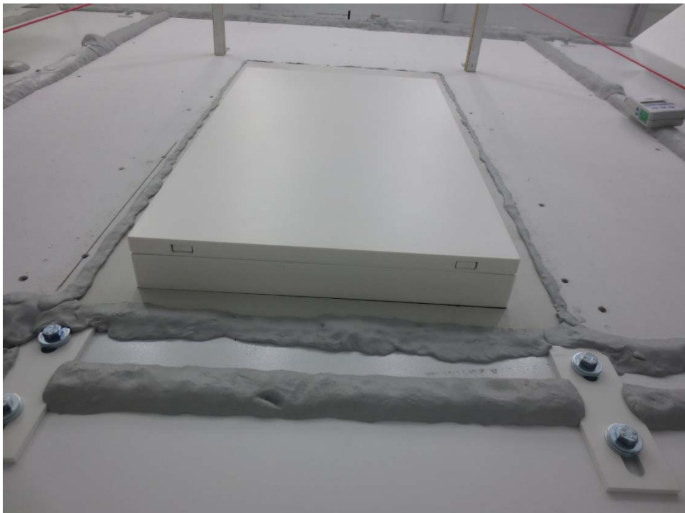
Abbildung E.8. Ein-Raum-Variante: Ansicht Innenseite unten (prüffertig).
