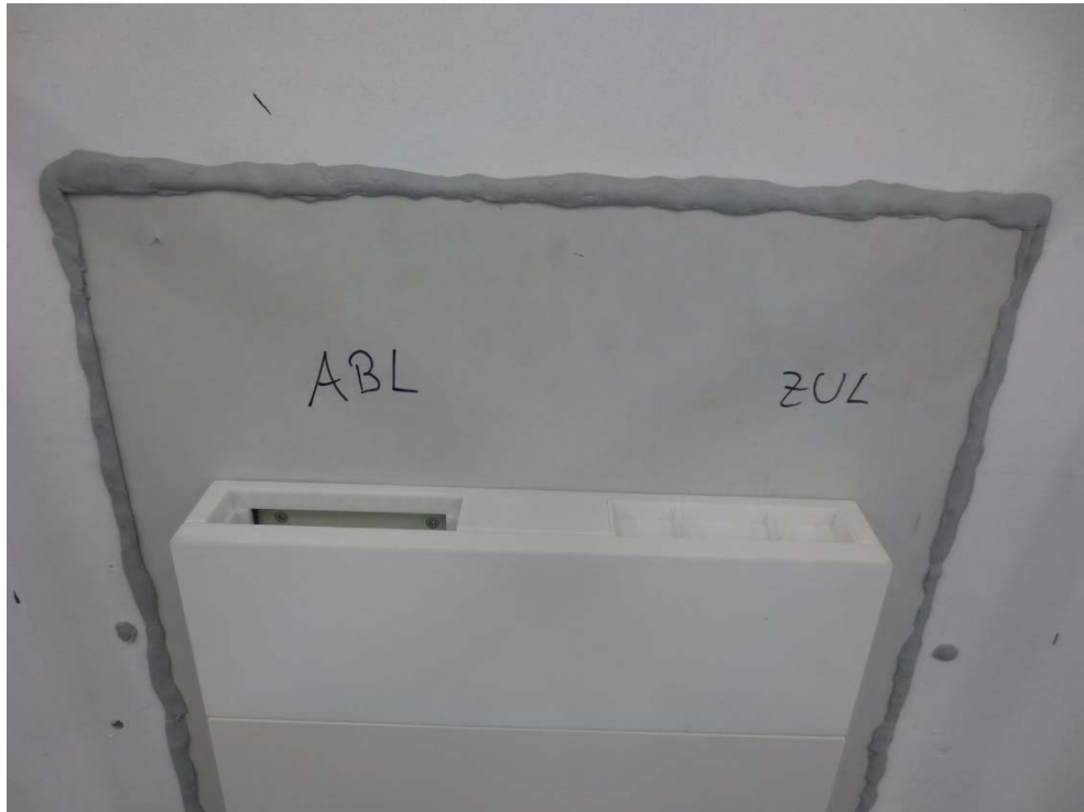
Abbildung E.17. Mehr-Raum-Variante mit Kanalanschluss ZUL-seitig; Ansicht Innenseite oben mit geöffneter ABL-Öffnung (prüffertig).
