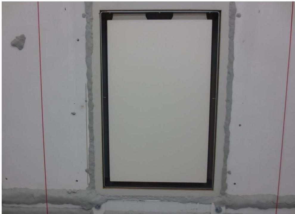
Abbildung D.2. Lüftungsgerät in Trockenbaublende montiert: Ansicht Innenseite noch ohne Abdeckung U<sup>2</sup>.
