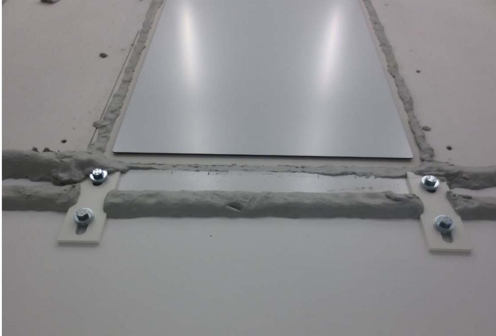
Abbildung D.3. Lüftungsgerät in Trockenbaublende mit Abdeckung U<sup>2</sup>.
