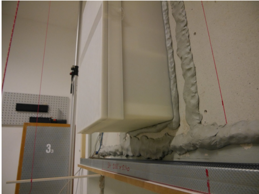
Abbildung B.9. Ansicht Lüftungsgerät innenseitig, prüffertig im Fensterprüfstand montiert und abgedichtet, Seitenansicht von schräg unten.
