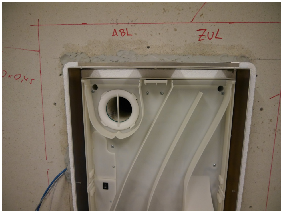
Abbildung B.6. Lüftungsgerät nach Montage in der Trockenbaublende, U 2 -Einbau mit Kanalanschluss ABL-seitig, Gerätedeckel entfernt, vor Montage der Kanäle und der VS-Schale.
