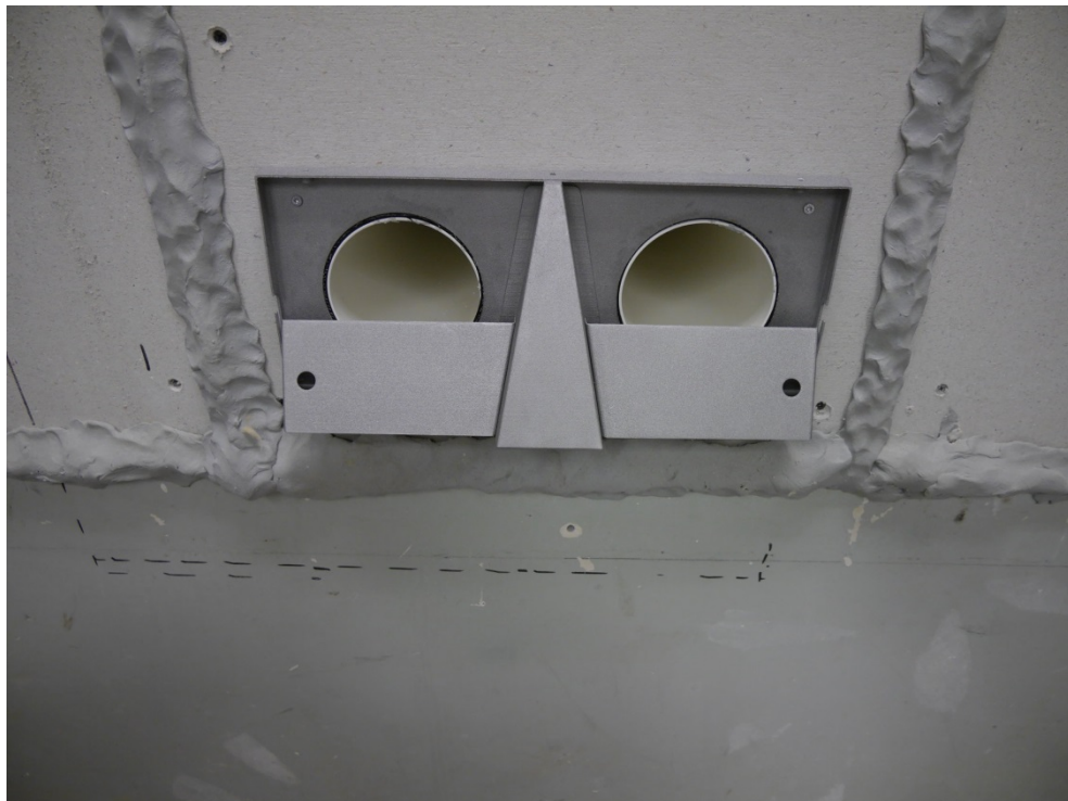
Abbildung B.4. Lüftungsöffnungen außenseitig mit teilweise montiertem Fassadenabschluss (Wandhalterung der Edelstahlschote).
