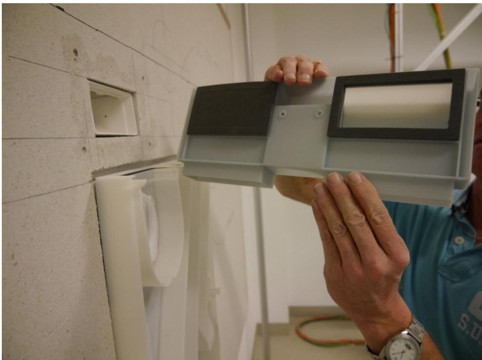
Abbildung D.14. Aufsetzen des Kanaladapters für UP-Einbau mit Kanalanschluss ABL-seitig.
