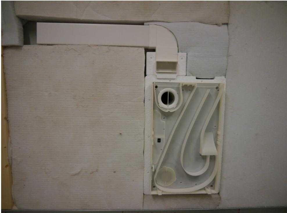
Abbildung D.13. Lüftungsgerät nach Montage in der Trockenbaublende, UP-Einbau mit Kanalanschluss ABL-seitig, Gerätedeckel entfernt, ABL-Kanal in der Vorsatzschale endend, Vorsatzschale gedämmt aber noch ohne Beplankung.
