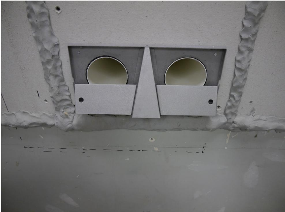
Abbildung D.5. Lüftungsöffnungen außenseitig mit teilweise montiertem Fassadenabschluss (Wandhalterung der Edelstahlschote).
