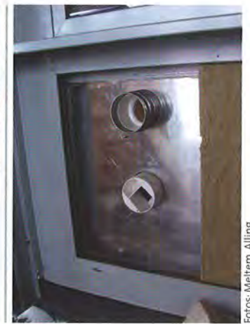
Die Be- und Entlüftungsstutzen werden im fertigen Bauzustand durch die neue Fassadengestaltung verdeckt
