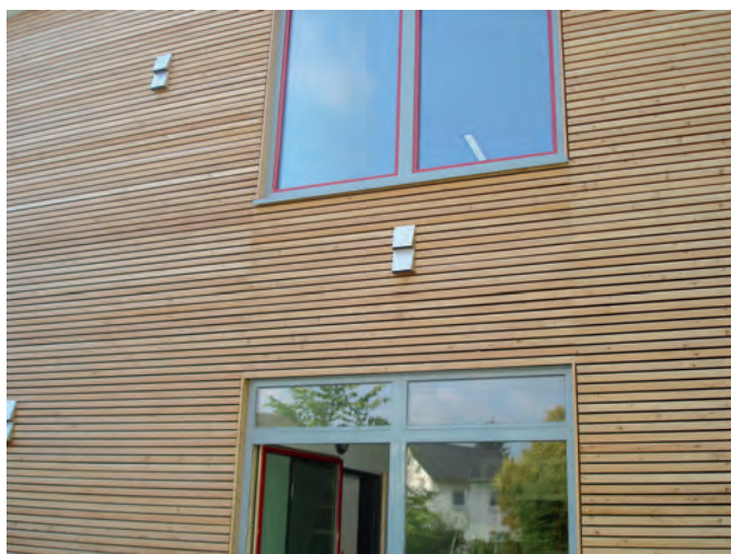
Bild 5. Auch oberhalb der großflächigen Verglasungen wurde für die Luftauslässe eine geradlinige Variante gewählt (Fotos: Meltem)
