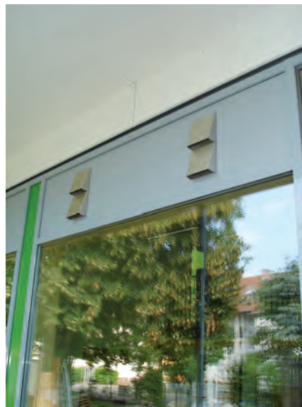
Bild 4. Die Lüftungsauslässe harmonieren gut mit der geradlinigen, modernen Holzfassade
