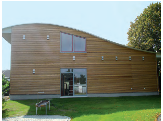
Bild 1. Der Neubau der Kindertagesstätte wurde in Holzrahmenbauweise errichtet
