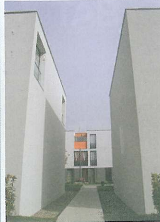
Bild 3: Die Zu- und Fortluft-Öffnungen wurden auf Wunsch des Architekten direkt in die Fensterleibungen integriert
