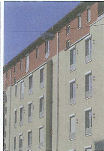
Bild 1: Im Wohngebäude Rollnerstraße erhielten die an der Ostseite des Hauses gelegenen Schlaf- und Kinderzimmer bzw. Arbeitszimmer dezentrale Lüftungsgeräte mit Wärmerückgewinnung
