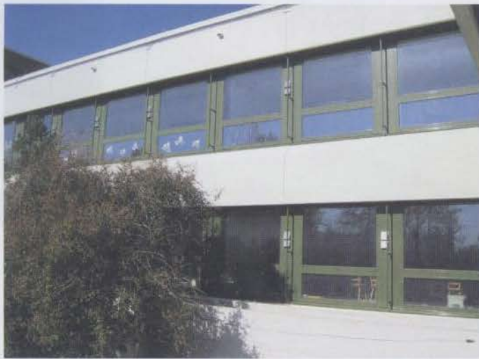
Die Ab- und Zuluftstutzen für die Lüftungsanlage wurden in die Profile der Fenster integriert
